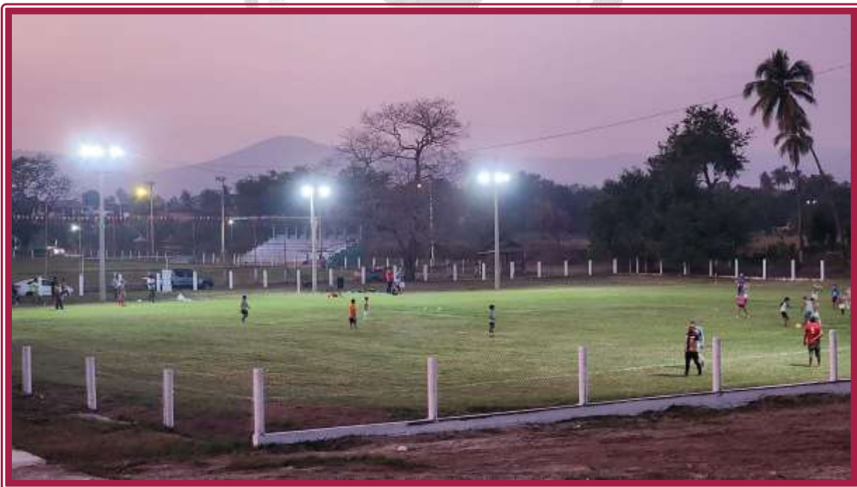
Obra: Rehabilitación de la Unidad Deportiva de la Localidad de Las Tunas; Municipio de Benito Juárez.
